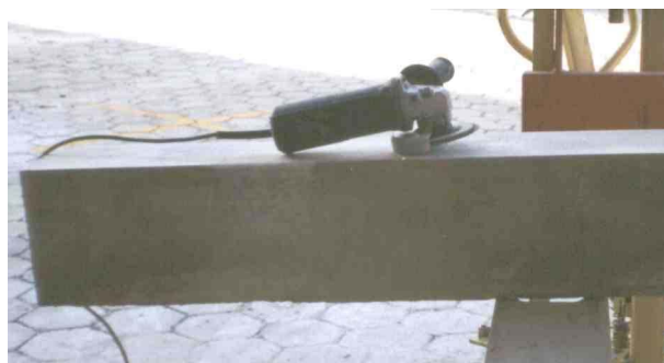
Figura 4: Preparação da superfície de concreto com disco de lixa grossa, acoplado à esmerilhadeira.
