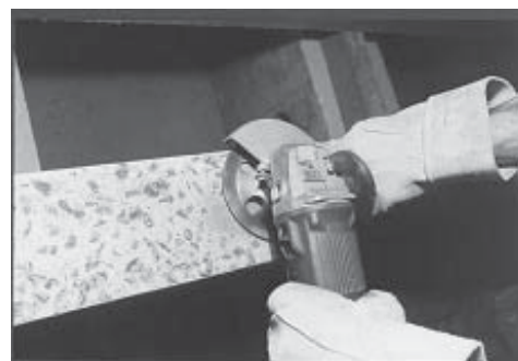
Figura 6: Preparação da superfície de concreto com esmerilhadeira para colagem da manta
