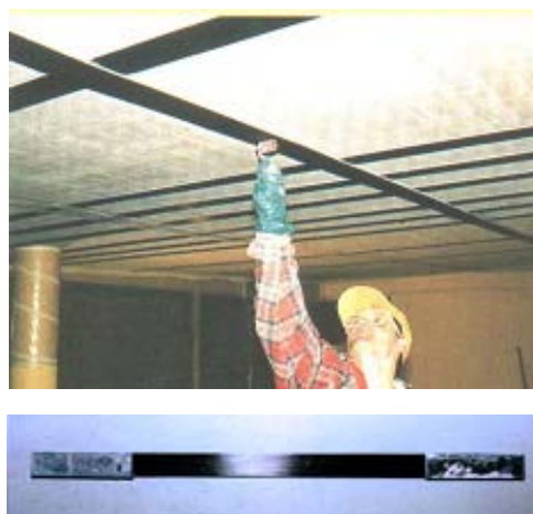
Figura 1: Aplicação do laminado (acima) e detalhe do laminado (abaixo) (Catálogo Sika)
