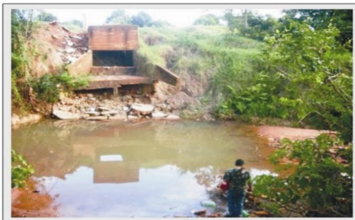
**Figura 3** Despejo da galeria pluvial no córrego da Ponte.
