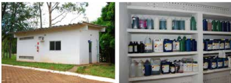
Figura 1. Recinto para armazenagem de resíduos sólidos classe 1 (perigosos). À esquerda vista externa e à direita vista interna
