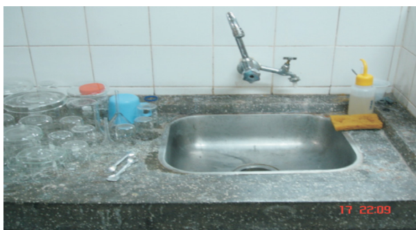
Figura 2. Pia com água encanada, detalhe para as vidrarias que se encontravam em cima da pia.
