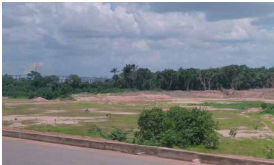
Figura 4. Retirada de argilas às margens da AM-070 (rodovia Manoel Urbano).
